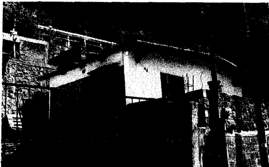
Las viviendas 1 y 2 están construidas con tabique rojo y castillos, sin techo con una dimensión de 20 y 25 m<sup>2</sup> respectivamente. La vivienda 3 esta construida con muros de block con techo de madera y lamina con una dimensión de 25 m<sup>2</sup> aproximadamente, cuenta con ventanas y puerta de herrería.
